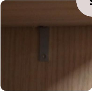
Dann befestigen Sie den Regalboden mithilfe der Eisenplatte an der Wand.
